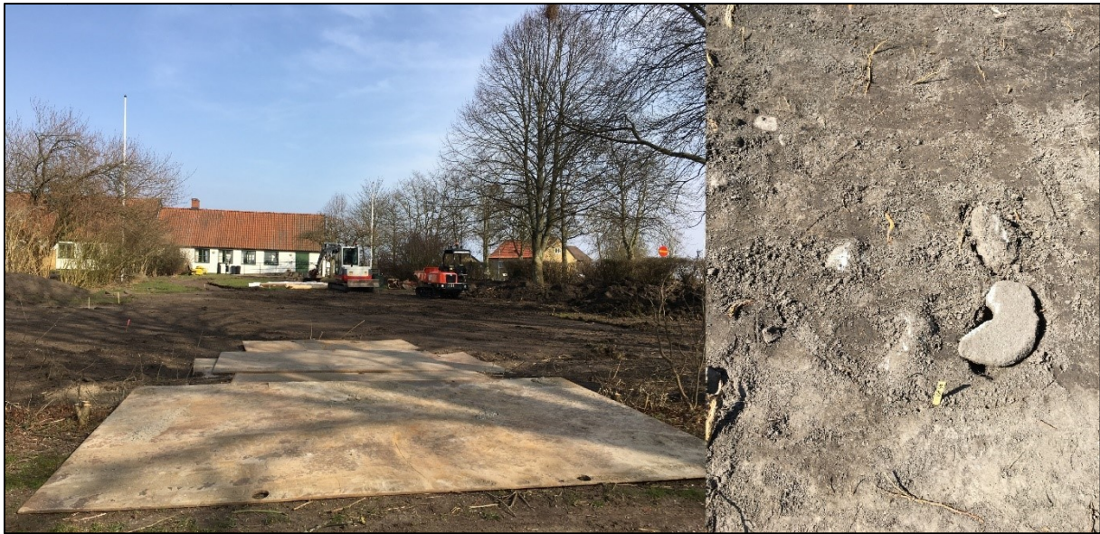
Figur 2. Schaktning av Trädgårdsområdet och påträffade anläggningar.
